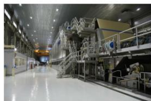
01.02.2019 Ремонт Сеgezской машины для производства бумаги
